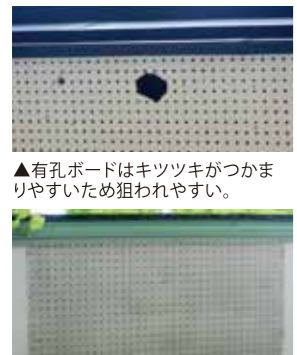
▲有孔ボードはキツツキがつかまりやすいため狙われやすい。 ▲ステンレスメッシュを貼った事例。キツツキから有孔ボードを守ります。
